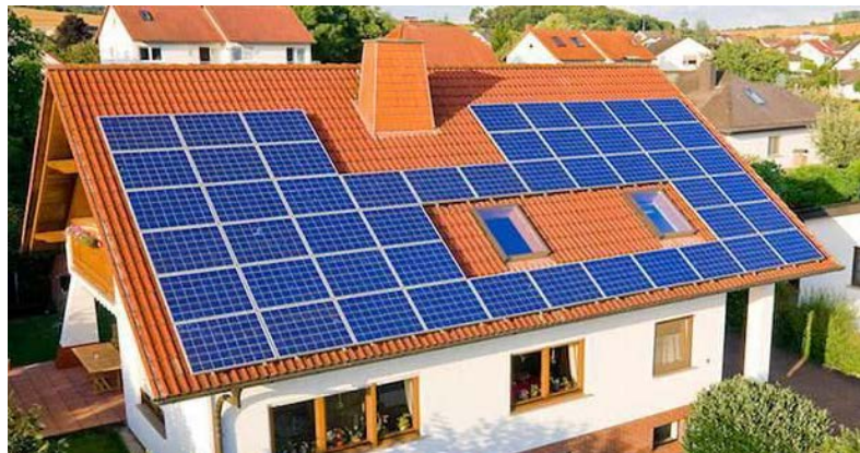
Şekil 55: Eysel PV sistemleri güneş ışığını elektrığe dönüştürerek evlere güç sağlar ve fazla enerjiyi şebekeye aktarır.
