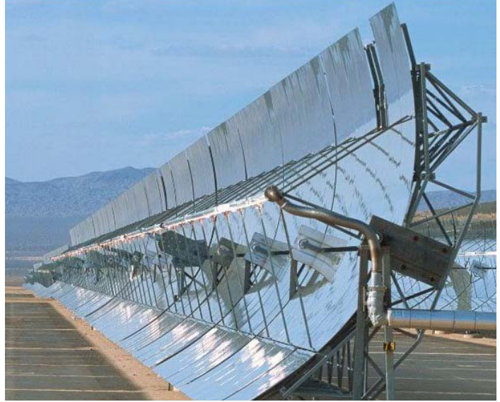
Şekil 50: Parabolik oluk kollektörleri, elektrik üretimi için yüksek sıcaklıkta ısı üretmek üzere güneş ışığını merkezi bir tüpe odaklar.
