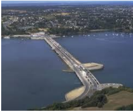
Şekil 93: Fransa'daki 240 MW kapasiteli Rance Gelgit Enerji Santrali, 750 metrelik barajıyla faaliyet gösteren dünyanın ilk ve en büyük gelgit enerjisi projelerinden biridir.
