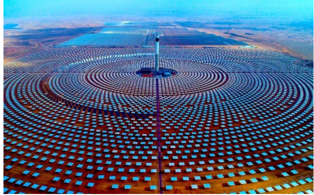
Şekil 39: “Yoğunlaştırılmış Güneş Enerjisi (CSP) sistemleri, güneş ışığını odaklamak ve elektriği verimli bir şekilde üretmek için aynalar kullanır.
