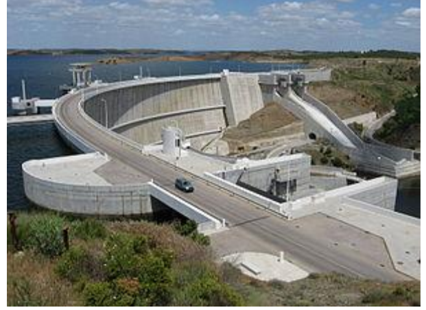
Şekil 76: Alqueva Barajı, Portekiz – Avrupa'nın en büyük barajlarından biri olup hidroelektrik enerji üretiliyor ve sulamaya destek sağlıyor.
