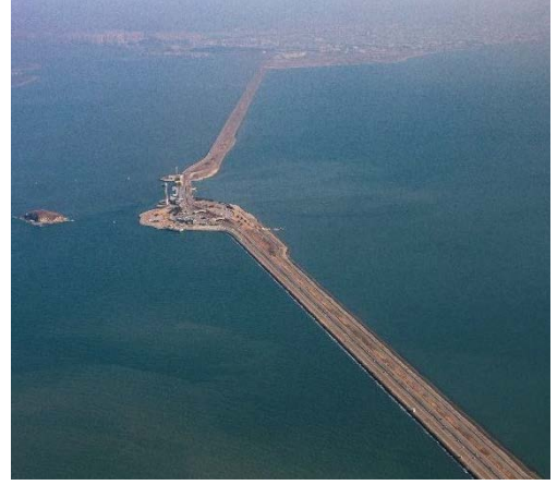
Şekil 94: Güney Kore'de bulunan Sihwa Gölü Gelgit Enerji Santrali, 254 MW kapasitesiyle dünyanın en büyük gelgit enerjisi tesisidir ve 2011 yılında tamamlanmıştır.
