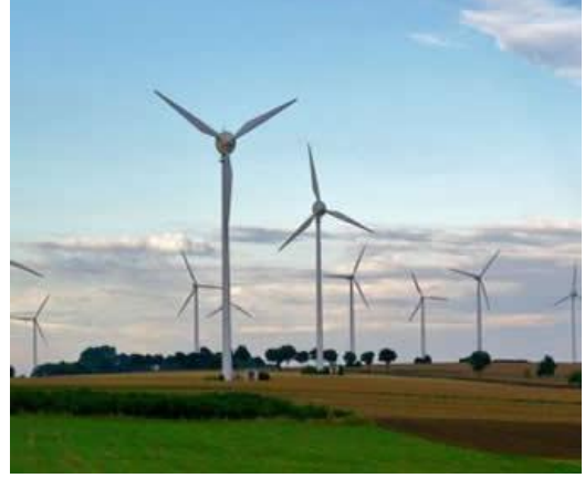
Şekil 61: Rüzgar türbinleri kinetik rüzgar enerjisinden elektrik üreterek temiz ve yenilenebilir bir enerji kaynağı sunmaktadır.
