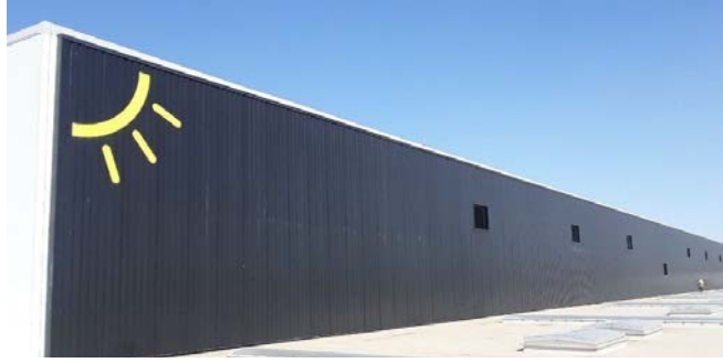
Şekil 43: SolarWall gibi camsız kollektörler havayı doğrudan ısıtır ve endüstriyel uygulamalarda kullanılır.
