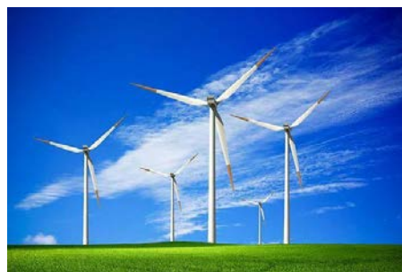
Εικόνα 66: Οι ανεμογεννήτριες με οριζόντιο άξονα είναι ο πιο ευρέως χρησιμοποιούμενος τύπος, ιδανικές για μεγάλης κλίμακας αιολικά πάρκα και υψηλή παραγωγή ενέργειας.
