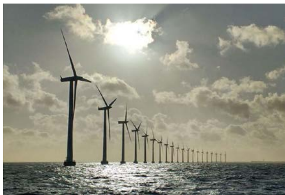
Εικόνα 69: Οι αιολικές τουρμπίνες ανοικτής θάλασσας εγκαθίστανται σε θαλάσσια περιβάλλοντα για να εκμεταλλευτούν τους ισχυρότερους και πιο σταθερούς ανέμους, αυξάνοντας σημαντικά την ικανότητα παραγωγής ηλεκτρικής ενέργειας.
