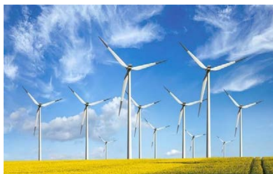
Εικόνα 58: Οι ανεμογεννήτριες μετατρέπουν την κινητική ενέργεια του κινούμενου αέρα, που αρχικά προκαλείται από τη θέρμανση της Γης από τον Ήλιο, σε καθαρή, ανανεώσιμη ηλεκτρική ενέργεια.
