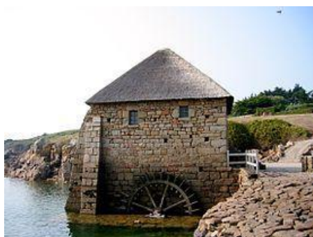
Εικόνα 102: Οι μύλοι παλίρροιας μετατρέπουν την κινητική ενέργεια των ρευμάτων της παλίρροιας σε μηχανική ενέργεια, η οποία ιστορικά χρησιμοποιούνταν για το άλεσμα του σιταριού.
